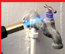
Dégel de canalisations
